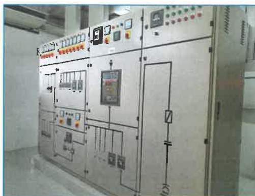
ระบบควบคุมไฟฟ้า MDB
